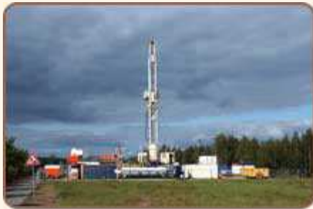
KSL-Bohranlage in der Tuchmacherallee im Spremberger Industriegebiet Ost.
